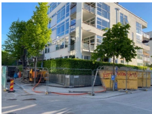
Borrning vid Sickla Kanalgåta 65
