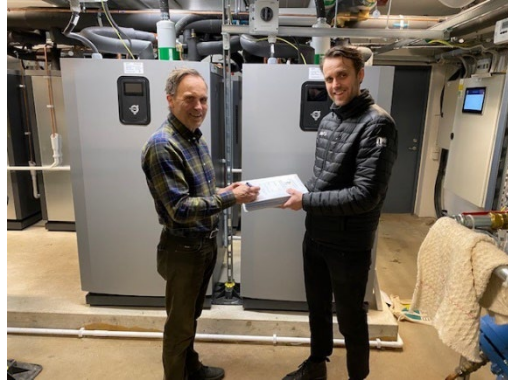
Efter färdig installation av borrhning och montage av 6 nya värmepumpar. ENSTARs projektledare Joakim Larsson lämnar över Driftpärmen till en nöjd Rolf Leidhammar – styrelsens projektledare.
