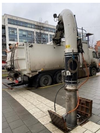
Sugbilen utanför Lugnets Allé 52
