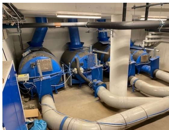
Sopor och bioavfall slängs ner i de blå rören – landar i sugkärlet och sugs ut till bilen
